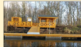
5. Budowa sieci tzw. zakątków wodnych w rejonie Jeziora Dąbie w Szczecinie
