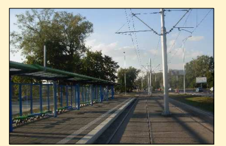
2. Budowa i przebudowa torowisk w Szczecinie (odcinek od Mostu Cłowego do Basenu Górniczego)
