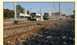
17. Budowa i przebudowa torowisk w Szczecinie - ETAP II
