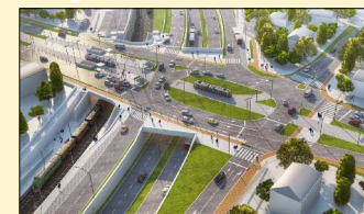
11. Budowa zintegrowanego węzła komunikacyjnego Łąko wraz z infrastrukturą na przebiegu Trasy Średnicowej dla obsługi wewnątrz aglomeracji ruchu pasażerskiego w Szczecinie
