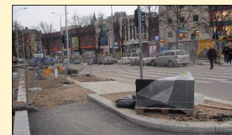
9. Przebudowa Alei: Niepodległości i Wyzwolenia
