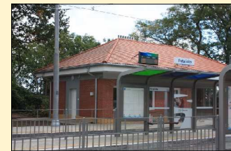
3. Przebudowa ulic: Potulicka - Narutowicza
