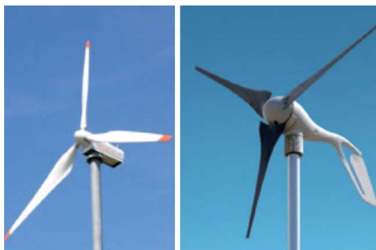
Rysunek 21 Turbiny o poziomej osi obrotu 205
