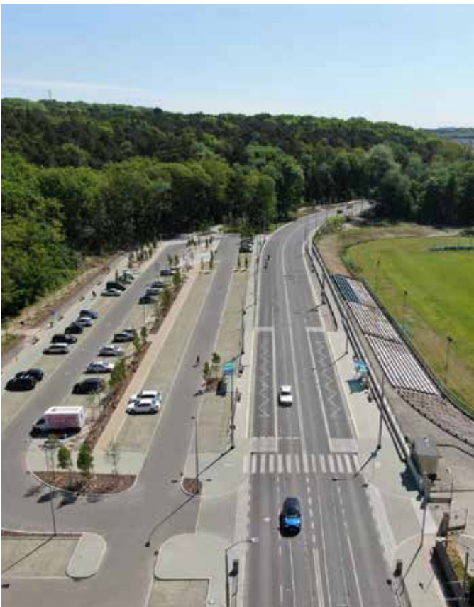
9) Przebudowa ulic: Niemierzyńskiej, Arkońskiej, Spacerowej do al. Wojska Polskiego, etap III - Przebudowa ul. Arkońskiej (od pętli tramwajowej „Las Arkoński” do al. Wojska Polskiego). Kwota: 18 595 041 zł
