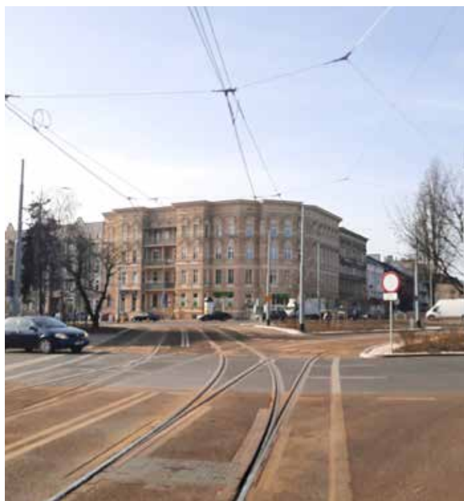
6) Budowa i przebudowa torowisk w Szczecinie - etap II. Kwota: 37 030 298 zł.
