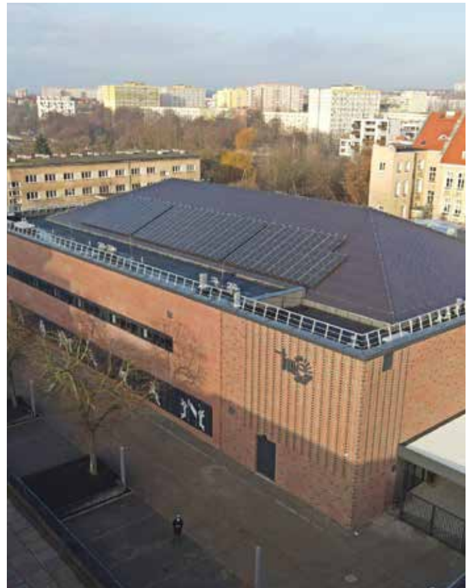
10) Budowa sali gimnastycznej w Zespole Szkół Elektryczno-Elektronicznych przy ul. Racibora 60/61. Kwota: 16 768 833 zł.
