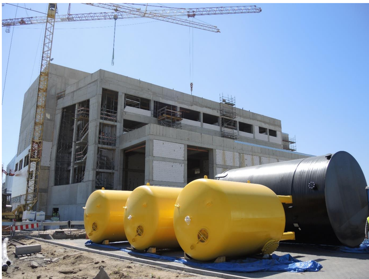
Fotografia 7 EcoGenerator w budowie, stan na czerwiec 2016 roku
