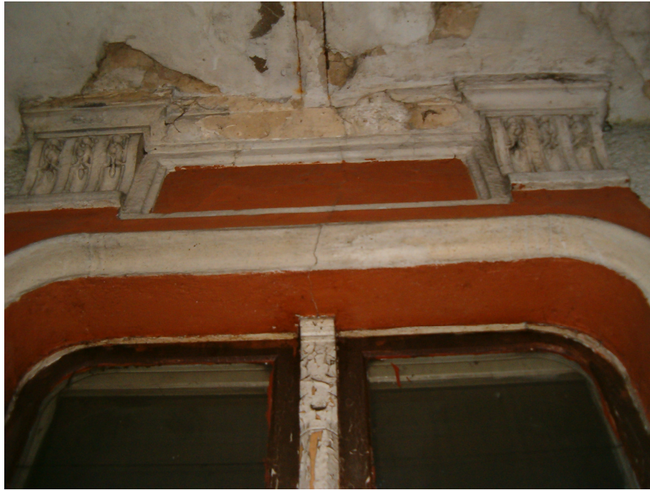
FOT.8. STROP NA BALKONIE
