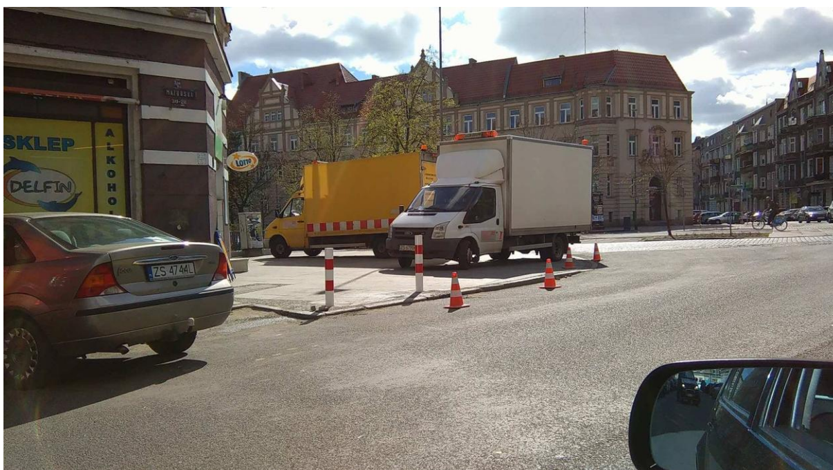
Zamontowane i jeszcze montowane słupki U-12c przy ul. Mazurskiej i w obrębie jej skrzyżowania z al. Jana Pawła II (fot. Mieszkaniec Szczecina)
