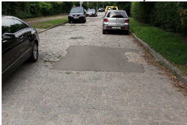
Fot. 2 Miejsce wykonania remontu cząstkowego z MMA
