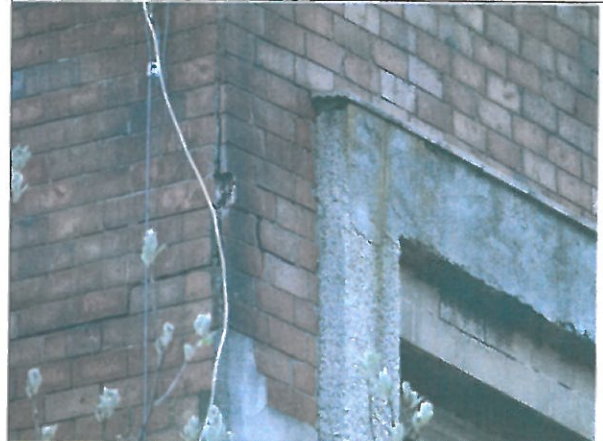
Fot. Uszkodzenia w ścianie budynku (rozwarstwienie zewnętrznej elewacji) mogą stwarzać warunki dla bytowania nietoperzy.
