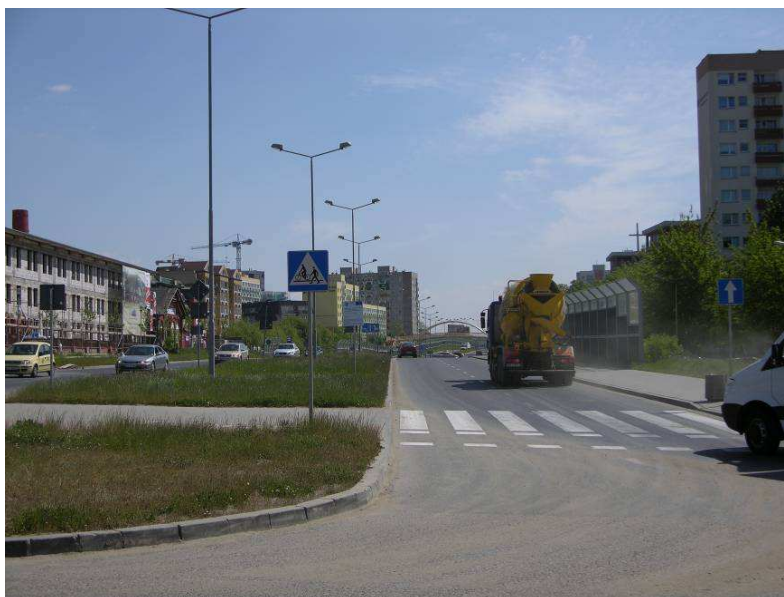
Obwodnica Śródmieścia Szczecina
