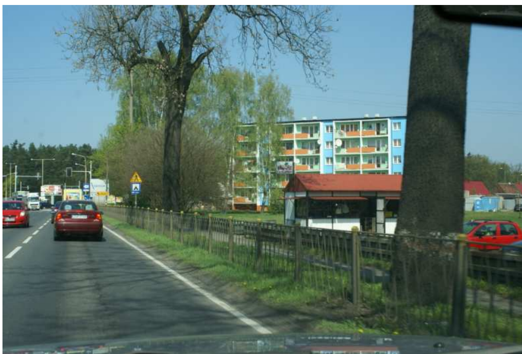
Fot. 6.1-5 W obszarze działania D2 po wschodniej stronie drogi istnieje możliwość realizacji ekranu akustycznego w miejscu istniejącej barierki bezpieczeństwa oddzielającej drogę od chodnika.
