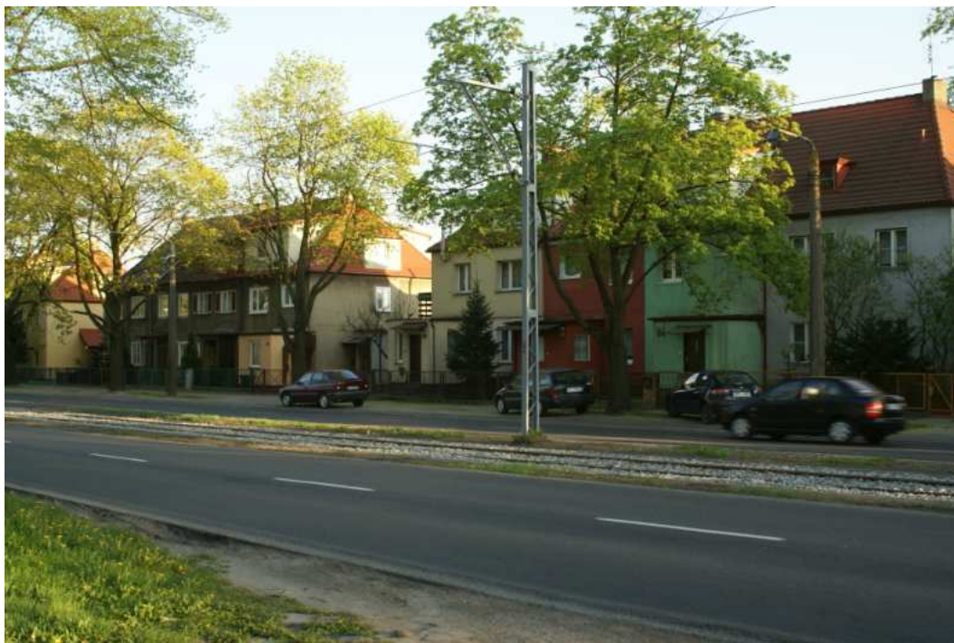
Fot. 6.1-47 Po południowej stronie ul. Ku Słońcu posesje mieszkalne znajdują się w niewielkiej odległości od jezdni – podobnie jak same budynki, co dyskwalifikuje ekran akustyczny jako rozwiązanie problemu nadmiernego hałasu.
