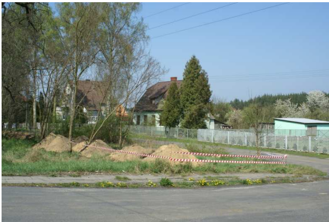
Fot. 6.1-2 Widok w kierunku północnym z terenu przed budynkiem mieszkaniowym przy ul. Pyrzyckiej 29A. Znaczna odległość pomiędzy zabudową a pasem drogowym stwarza możliwość realizacji skutecznego ekranu akustycznego
