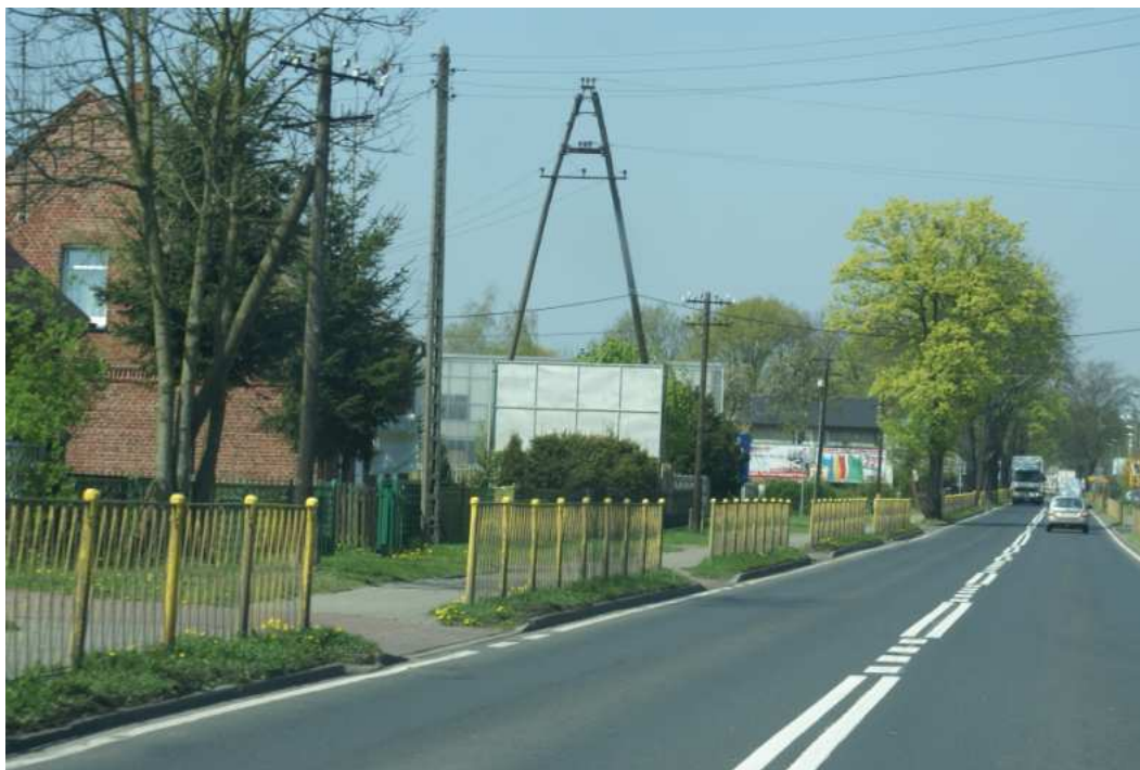
Fot. 6.1-3 Na przeważającej długości odcinka drogi w obszarze działania D1 znajduje się duża liczba włączyń do drogi głównej. Uniemożliwia to zaprojektowane skutecznego ekranu akustycznego.
