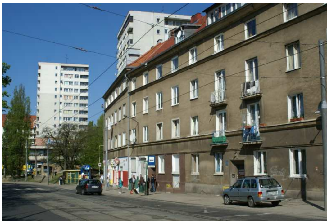
Fot. 6.1-35 Zabudowa wielorodzinna 5 kondygnacyjna przy ul. Druckiego – Lubbeckiego narażona na hałas potęgowany przez bardzo zły stan nawierzchni drogowej, oraz zły stan linii tramwajowej.
