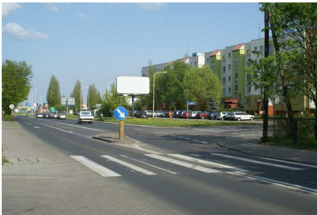
Fot. 6.1-12 W sąsiedztwie skrzyżowania ulic Gryfińskiej oraz Strug znajduje się budynek mieszkalny wielorodzinny, który może być skutecznie chroniony przed hałasem od ulicy Gryfińskiej ekranem akustycznym.
