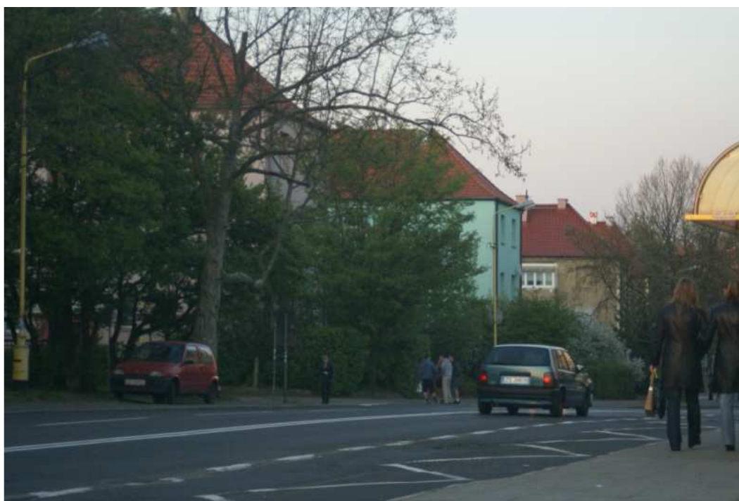
Fot. 6.1-53 Zabudowa mieszkaniowa znajduje się w bezpośrednim sąsiedztwie ulicy, co w znacznym stopniu utrudnia realizację ekranu akustycznego.
