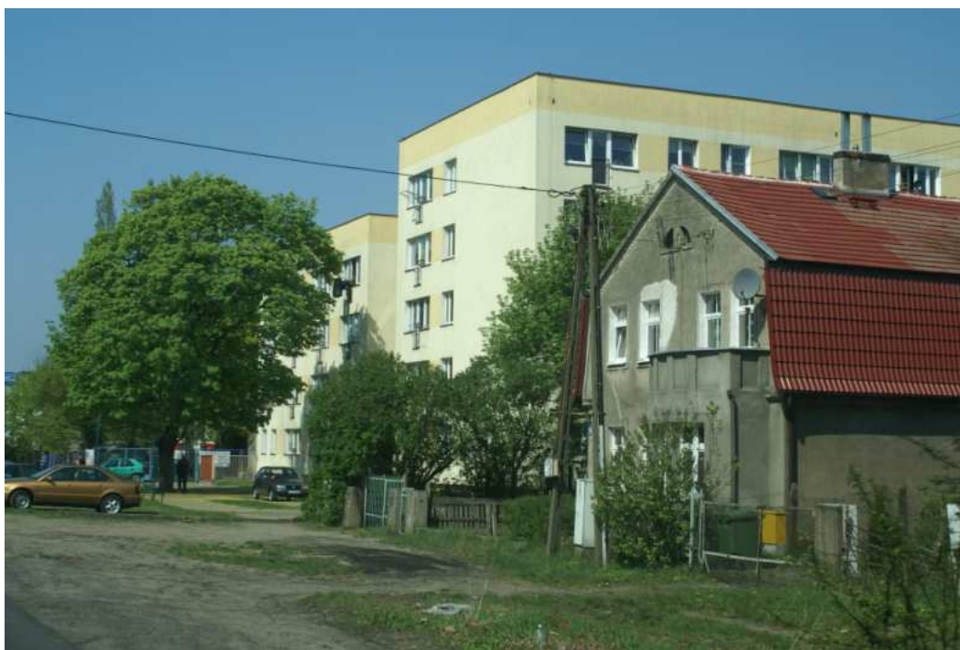
Fot. 6.1-9 W obszarze działek D5 znajduje się zabudowa mieszkaniowa jedno i wielorodzinna. Niezainwestowany obszar pomiędzy ul. Pomorską a budynkami stwarza dogodne warunki dla realizacji skutecznego ekranu akustycznego.
