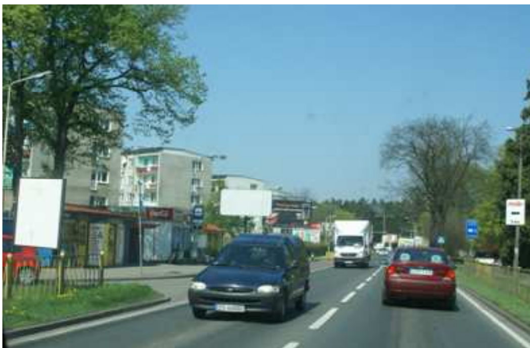
Fot. 6.1-4 W obszarze działania D2 istnieje możliwość realizacji ekranu akustycznego zarówno po wschodniej jak i zachodniej stronie drogi.
