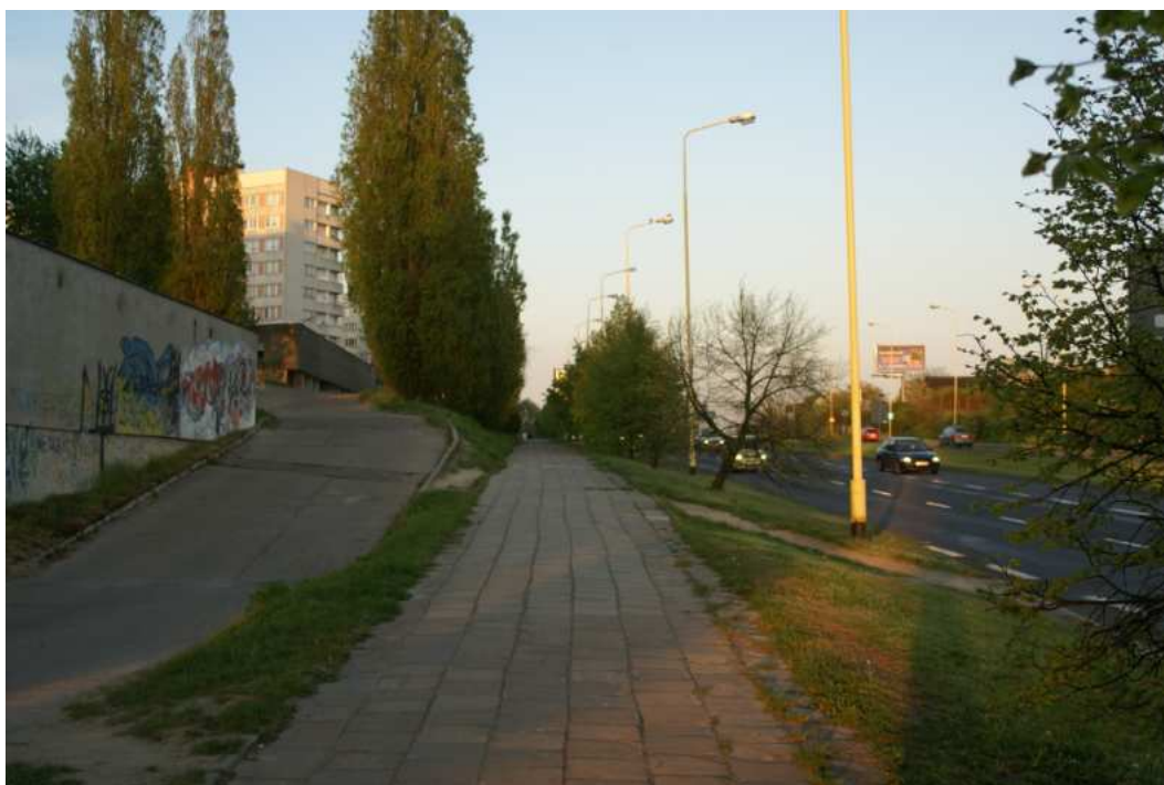
Fot. 6.1-50 Budynki mieszkalne przy ul. Kaliny i Derdowskiego w małym stopniu chronione są przed hałasem od ul. 26-go Kwietnia wyniesionymi nad poziom drogi ciągami garaży. Jednakże w cieniu akustycznym znajdują się wyłącznie dolnej kondygnacje.
