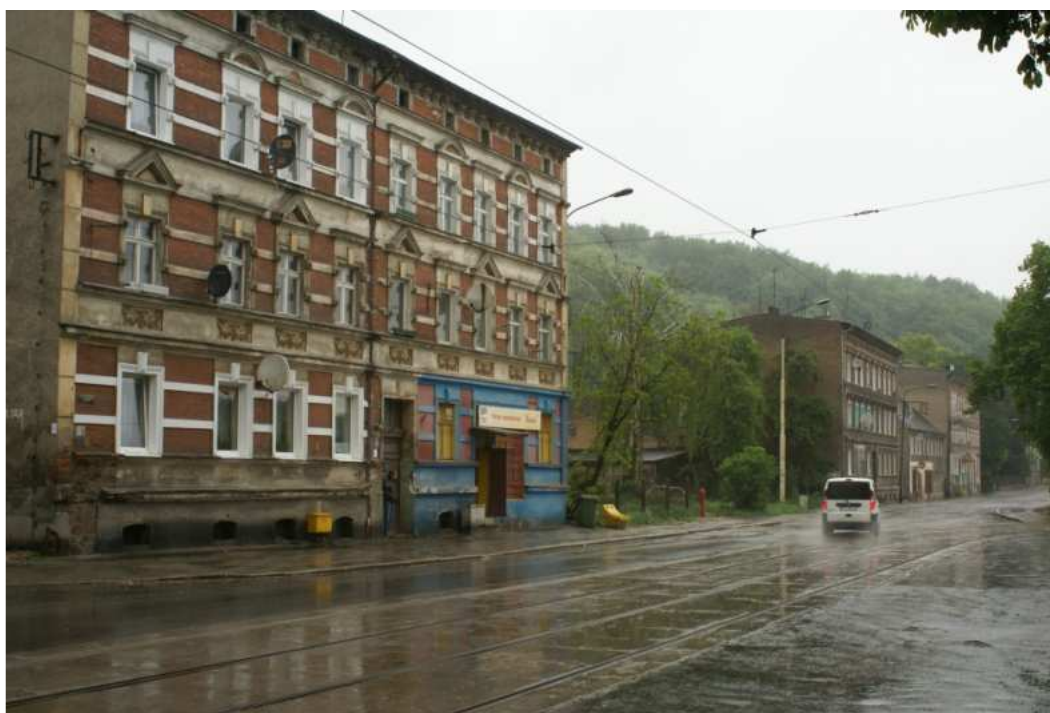
Fot. 6.1-29 Zabudowa mieszkaniowa wielorodzinna przy ul. Lipowej znajduje się w bezpośrednim sąsiedztwie pasa drogowego (rejon zjazdu tramwajów na pętlę). Na pierwszym planie budynek nr 22
