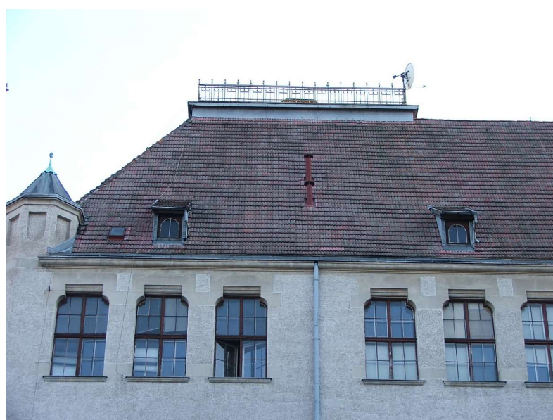
Fragment elewacji zachodniej
