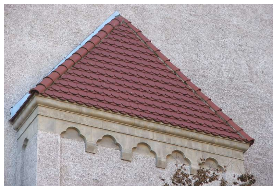
Elewacja od strony wschodniej, połąć dachu i wykusz, pokrycie wymienione w 2003 roku
