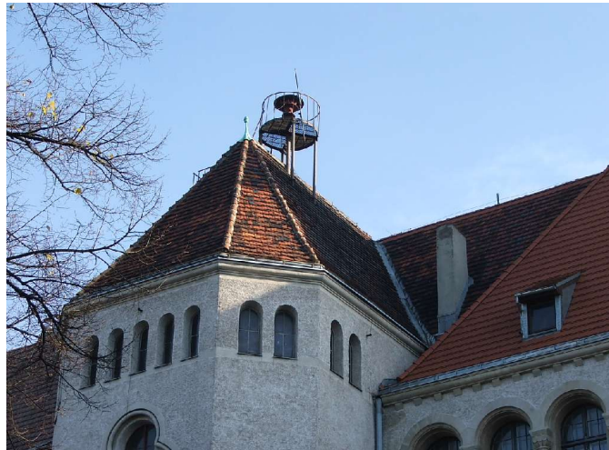
Wieża na elewacji zachodniej, od podwórza
