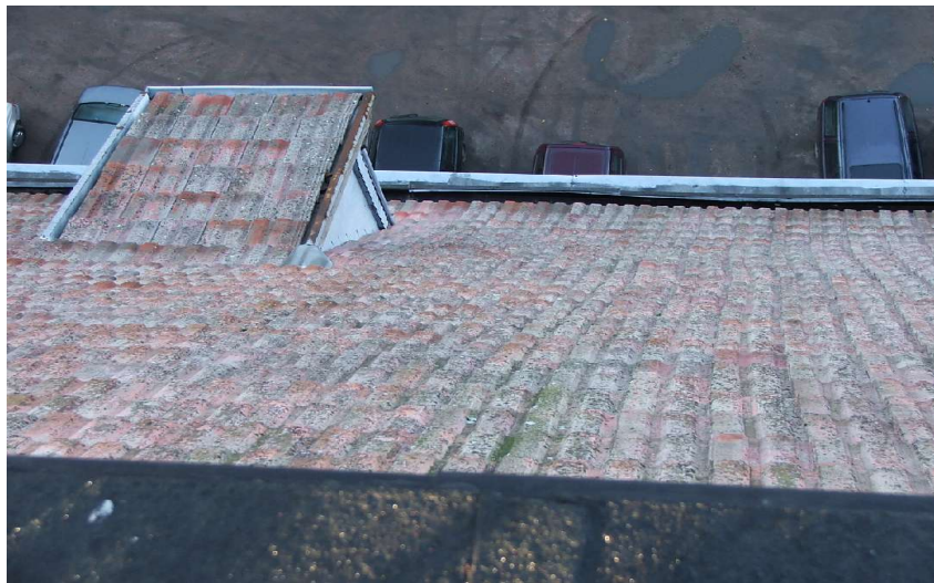
Połączenie dachu od strony zachodniej widziana z tarasu
