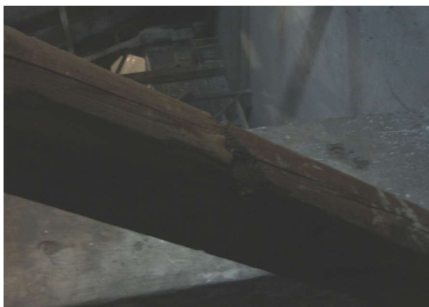
Uszkodzenia zastrzału
