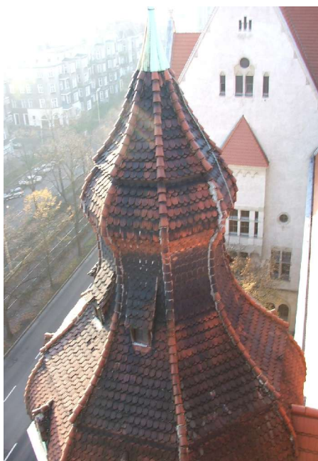
Wieża od strony al. Piastów
